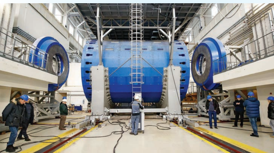
Технологическое перемещение 800-тонного соленоида детектора MPD
