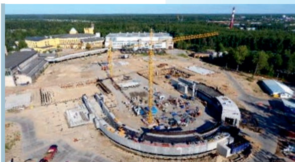
Строительная площадка комплекса NICA
