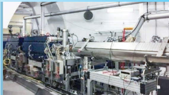
Ввод в эксплуатацию HILac
