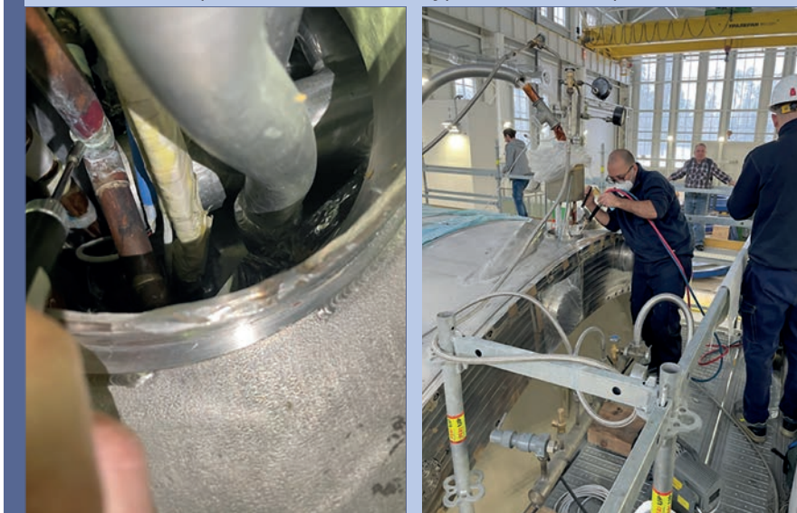
Локализация и ремонт азотного контура теплового экрана соленида
