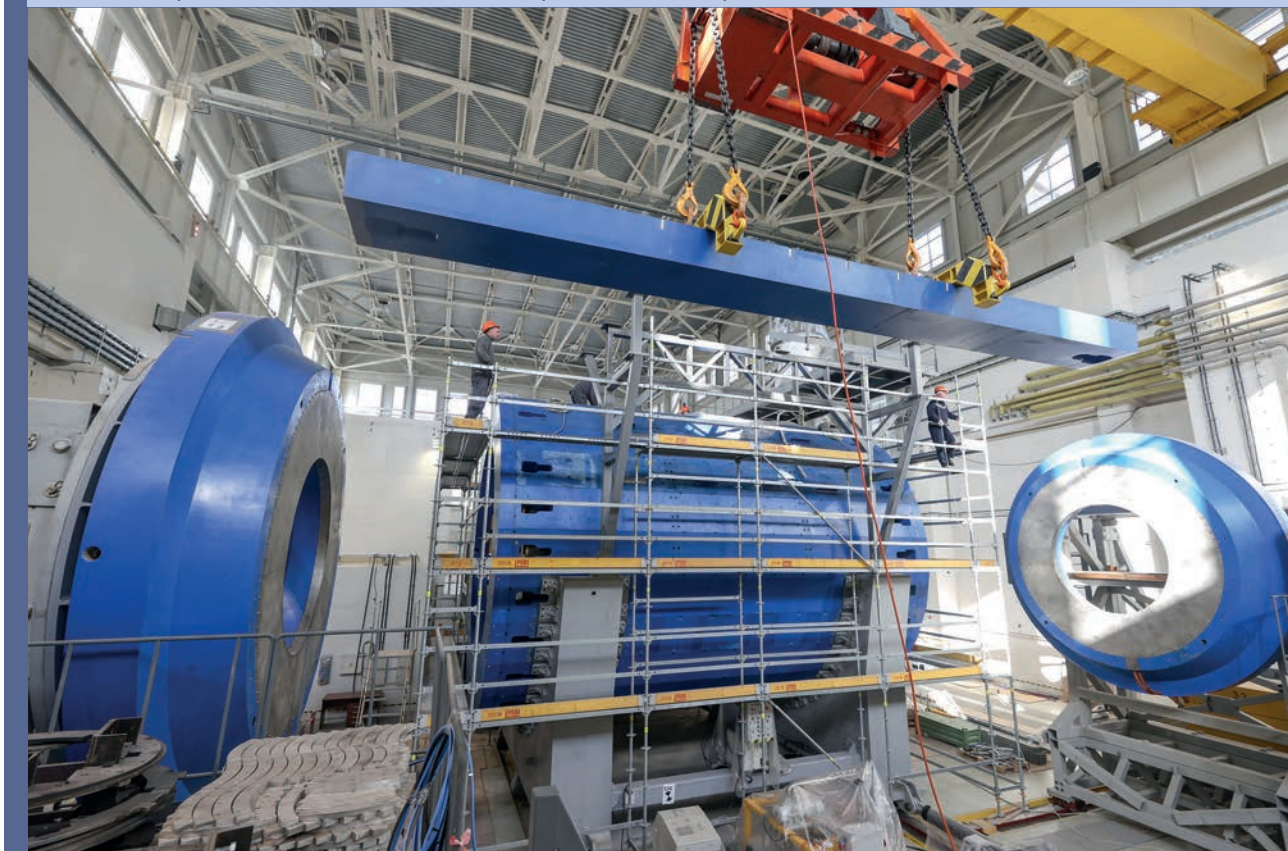
Установка трех последних балок магнитопровода детектора MPD
